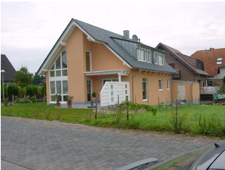
Bild 2: Ansicht des Bewertungsobjekts aus nordwestlicher Richtung
