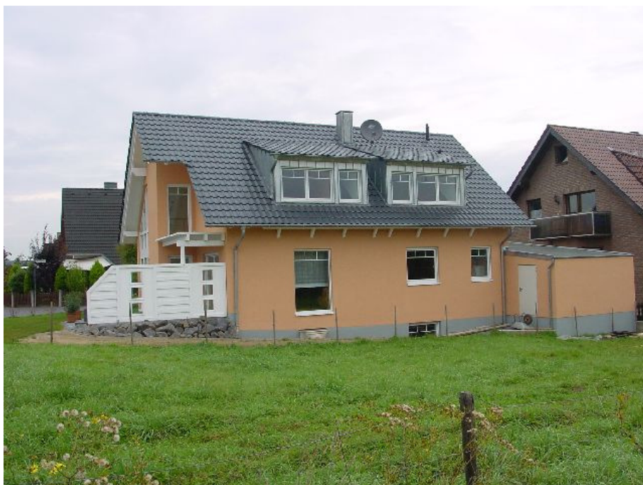
Bild 3: Ansicht des Bewertungsobjekts aus südlicher Richtung
