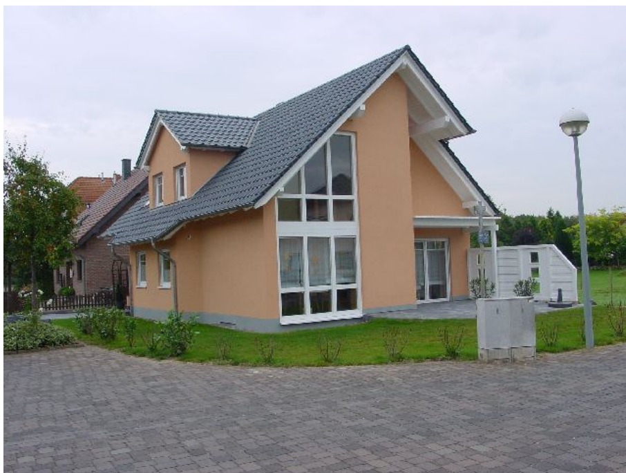
Bild 1: Ansicht des Bewertungsobjekts aus südwestlicher Richtung
