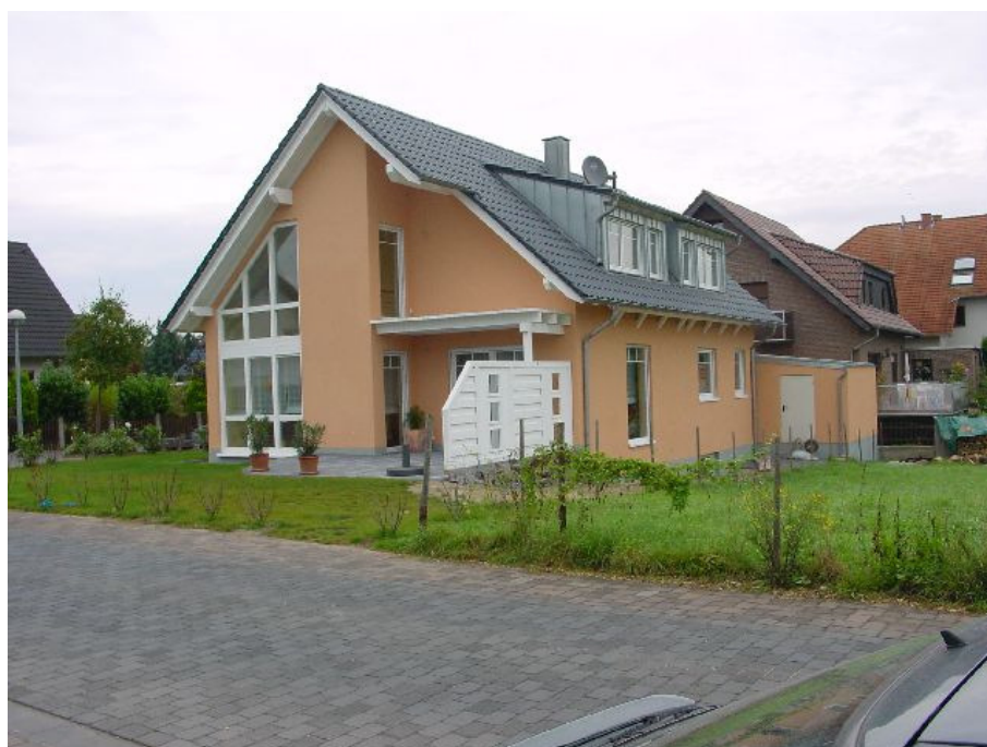
Bild 2: Ansicht des Bewertungsobjekts aus nordwestlicher Richtung
